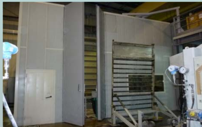
Panelado acústico con puertas y visor
